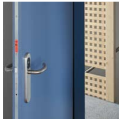
... die Wohnungseingangstüren mit Mehrfachverriegelungen ...
